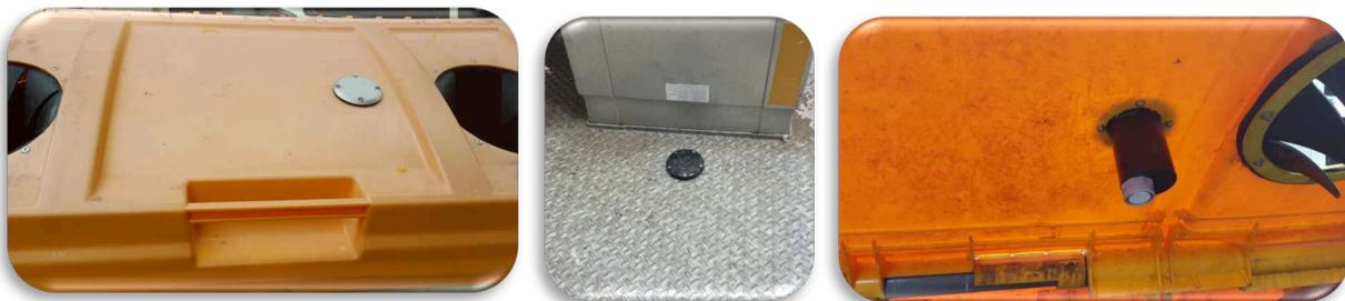
Sólo se necesita una corona para realizar el agujero central, un taladro para hacer 4 agujeros y seguidamente se coloca. Para los enterrados, se usarán tornillos tipo tirafondos y para los de superficie pueden usarse tornillos con rosca o bien remaches.
